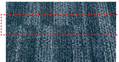
リピートを合わせずジョイントした場合
