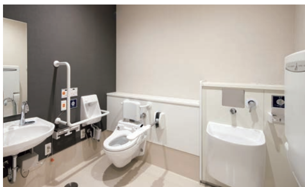
上：リハビリセンター 下：多目的トイレ
