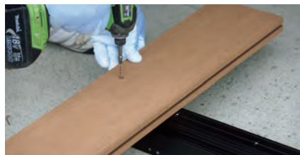
① 起点となる床材を皿ドリルねじで固定します。
