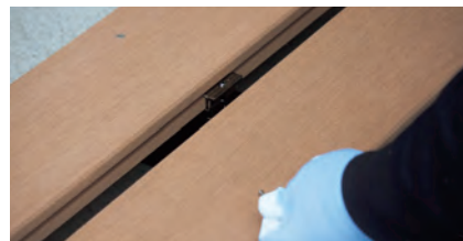
③ ジョイントブラケットを挟むように床板を並べていきます。
