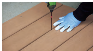
⑥起点と終点の間にある床材位置を調整後、ジョイントブラケット用ビスで固定します。
