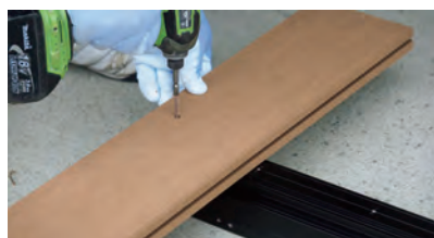
①起点となる床材を皿ドリルねじで固定します。
