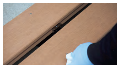
③ジョイントブラケットを挟むように床板を並べていきます。
