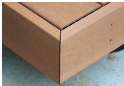
エッジを際立たせるデザイン性の高いコーナー納まり。 ※現場で45度カット作業が必要になります。
