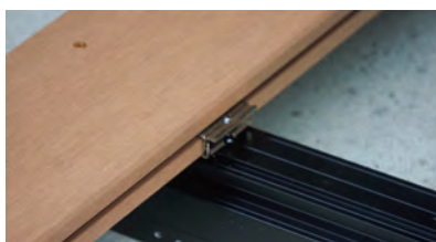
②ジョイントブラケットを仮付けします。
