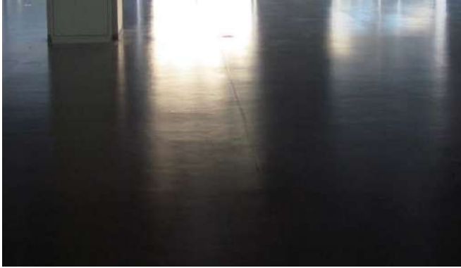
凹凸が目立たず良好な仕上がり 床下地表面凹凸:グレードB (2m直定規で隙間2mm未満)
