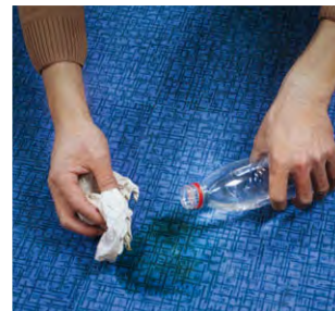
C.最後に綺麗な水(またはお湯)を用いてリンスしながら、スクレイパーなどで汚水を集めて雑巾で吸い取ってください。必要に応じて数回繰り返してください。
