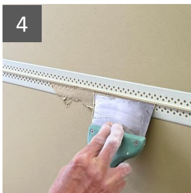
パテ（下塗り）① アタッチメントの穴をしっかりと埋める
