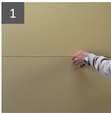
壁面に墨出し
