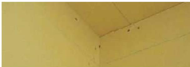
4、施工するモールドで 30cm 程度のカット片を 2 枚作り、水平軸、垂直軸の角度調整ができる押し切り電動スライダを用いて何度か試し切りをしながら入隅の水平軸、垂直軸の角度を割り出していきます。大方の角度を割り出した後に小口微調整をカンナで行います。
