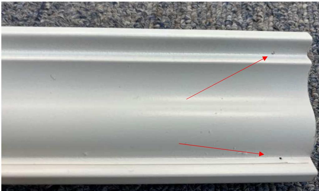
7、モールドの施工が終了したら、直線部、入隅、出隅のジョイント、フィニッシュネイル跡に水性コーキングを充填して綺麗におさめます。
