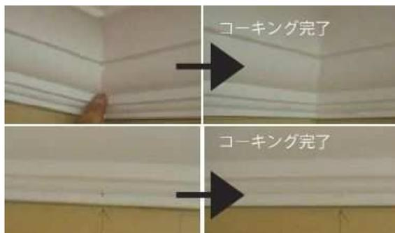
8、施工箇所を見て回り、コーキング補修不備、フィニッシュネイルの浮き等がないか確認し、施工を完了します。
