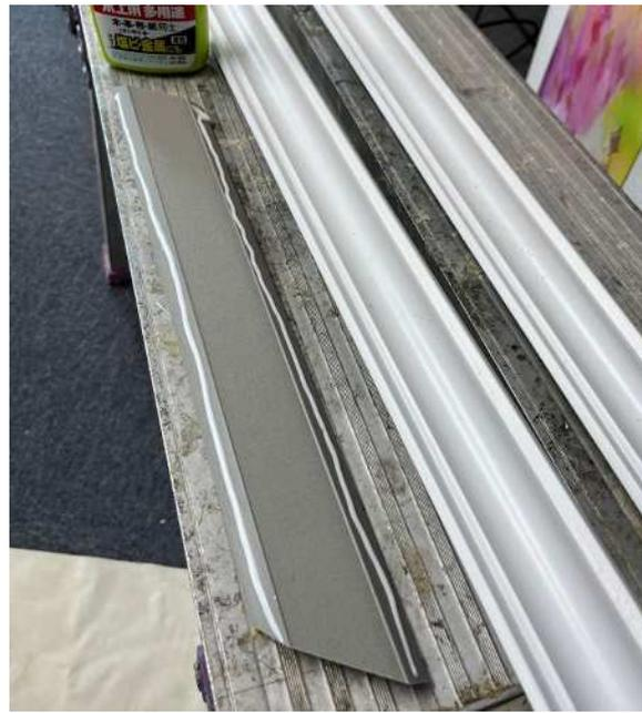
6、モールドを墨線に合わせて固定し、コンプレッサーに接続したフィニッシュガンでピンネイル（推奨）、またはフィニッシュネイルを打って固定していきます。ネイルの施工スパンは、商品の大きさにもよりますが、約 50cm 程度の間隔で打っていきます。
