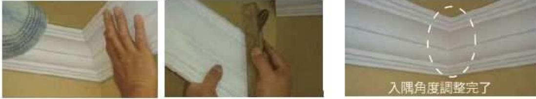
5、壁・天井面に接する部分へ均一に水性木工用・多用途ボンドを塗ります。はみ出したボンドは軽く水で濡らしたウエス等で拭き取ってください。
