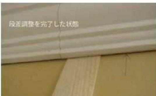
段差調整後に、再度ジョイント付近にフィニッシュネイルを打ち、モールドを完全に固定します。その後、ベニアクサビのはみ出た部分をカッターでカットします。
